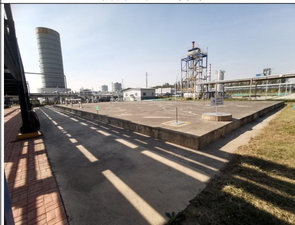
事故应急池、初期雨水池（侧面）
