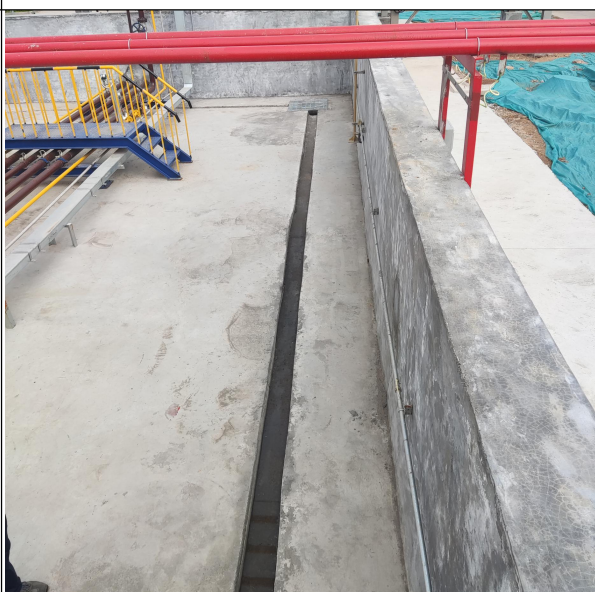
罐区围堰（内部）
